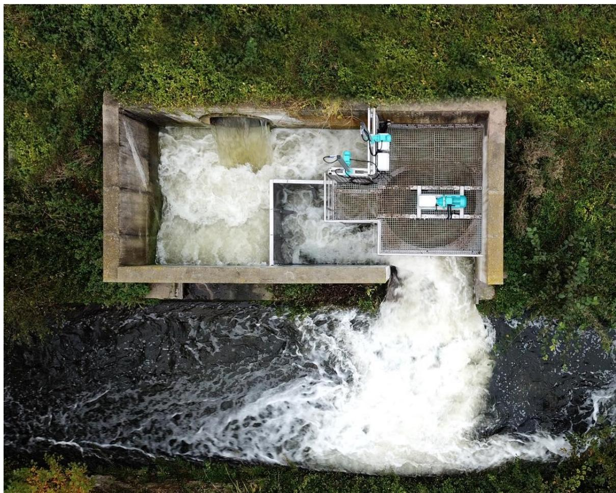
Hidroelektrana od 5,5 kW je instalirana u postrojenju za prečišćavanje otpadnih voda u Versaju sa nominalnim protokom od 0,7 m<sup>3</sup>/s i visinom vode od 3,2 m. Turbina je postavljena da snabdeva strujom Carre de Reunion, postrojenje za prečišćavanje otpadnih voda bez
