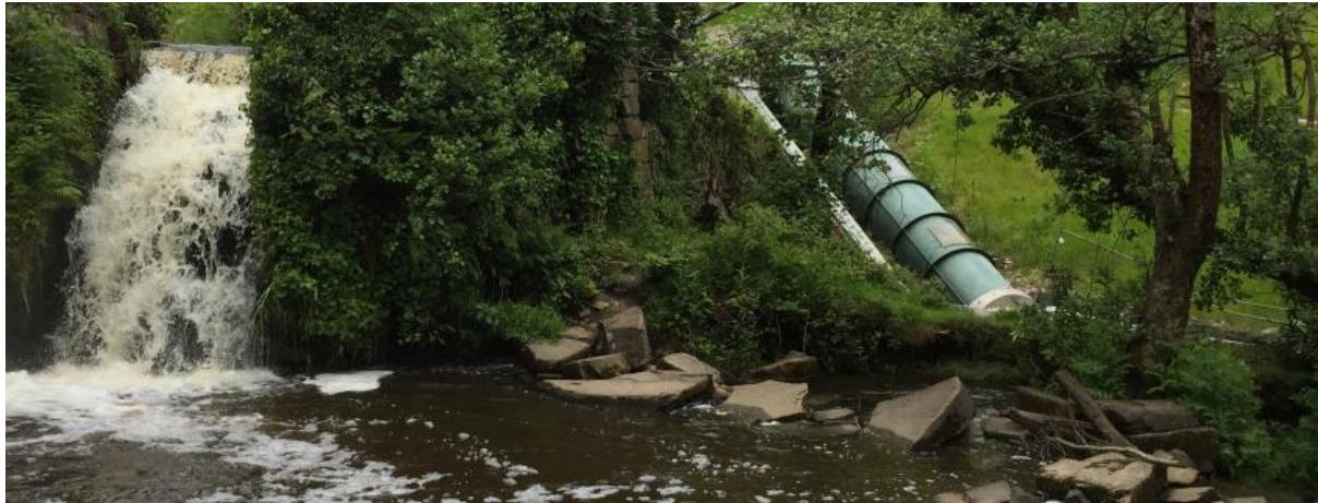
Dvanaestometarska Arhimedova pužna turbina je instalirana pored vodopada u Penllergare-u u Velikoj Britaniji. Ova turbina proizvodi električnu energiju za vizitorski centar, koji se nalazi u blizini, dok se višak isporučuje u nacionalnu mrežu. Puž turbina se odlikuje visokom efikasnošću i omogućava lak prolaz ribama.
