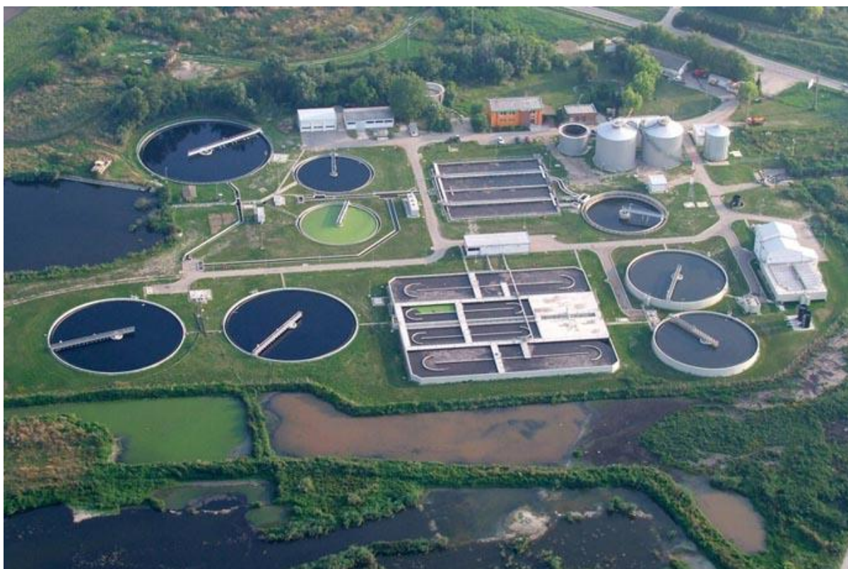
Инсталация за производство на биогаз от отпадъчни битови води
