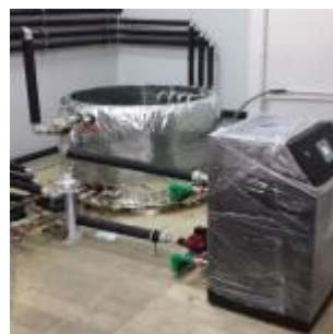
ТП свързана с акумулацията на топла и студена вода
